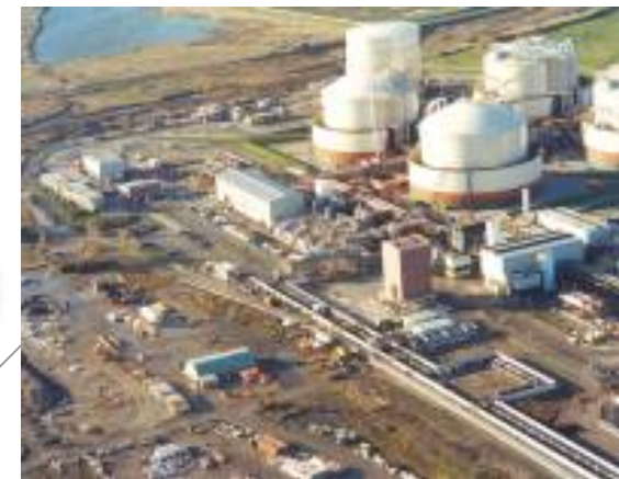
Isle of Grain LNG Terminal in Kent
